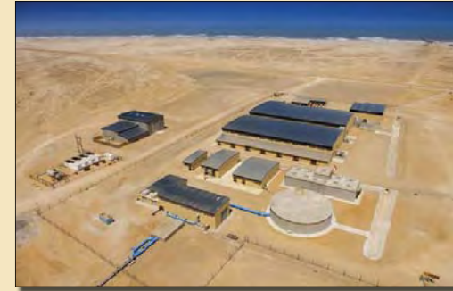
Die bereits bestehende Meerwasser-Entsalzungsanlage an der Küste nördlich von Swakopmund.
