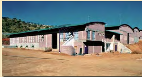
Das Gebäude der Wasseraufbereitungsanlage Goreangab
