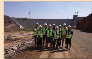
Die Neckartal-Staumauer kurz vor der Vollendung
